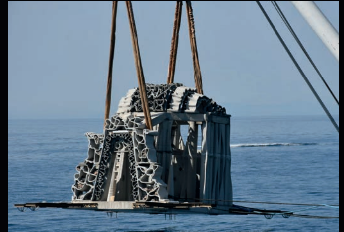
Récif Lab - Récif de déport de pression béton armé Cap d'Agde, Ile de Brescou
