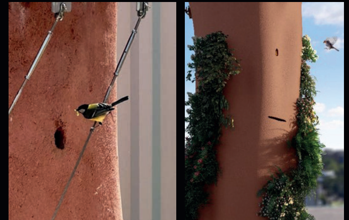
Mâts télécom béton impression 3D + béton de terre, Plusieurs villes en France
