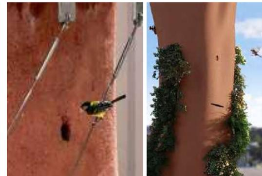
Mâts télécom béton impression 3D + béton de terre
