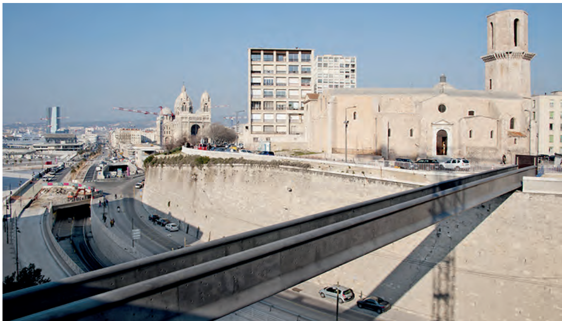
Passerelle de 69 m de portée BFUP - Brèche, voies routières
