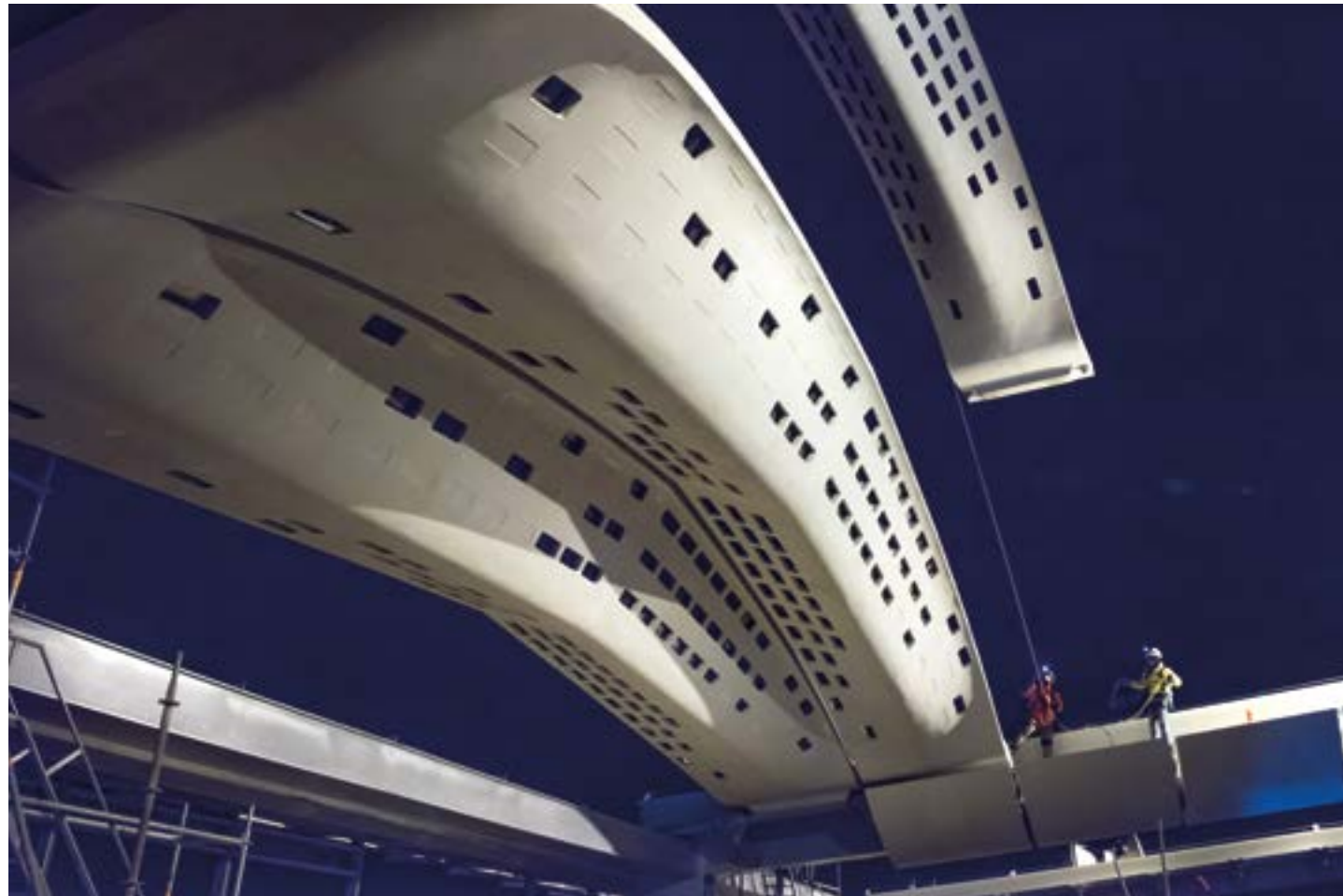
▲ Coques précontraintes en BFUP blanc formant la couverture de la gare TGV de Montpellier (architecte: Marc Mimram).
